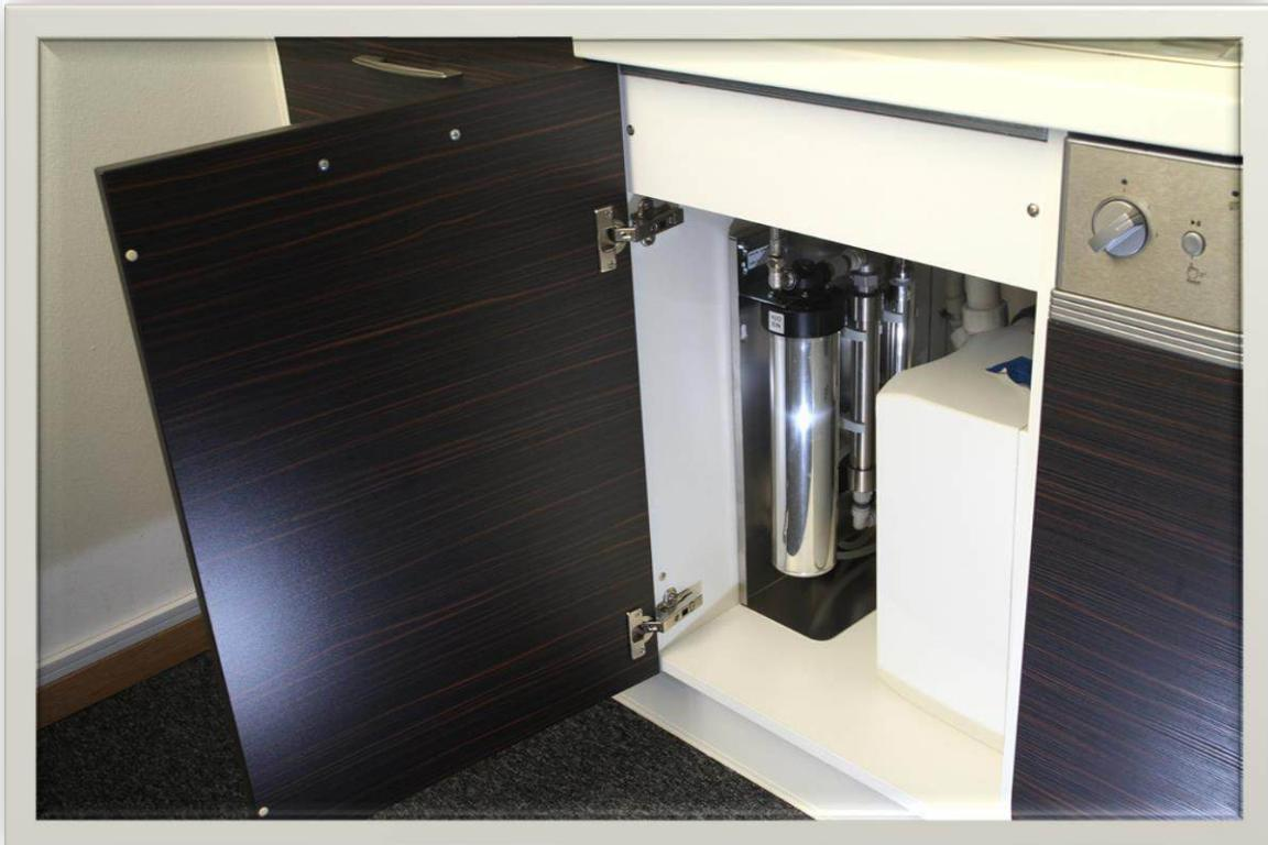
Die Wellwasser-Aufbereitungsanlage wird am Eckventil der Kaltwasserleitung angeschlossen. Alternativ können Sie zum Zapfen von wellwasser<sup>®</sup> eine separate Kaltwasserarmatur installieren. (links im Bild)
